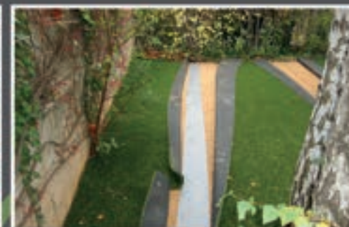
12 / Mise en place de la bande de jonction - colle
