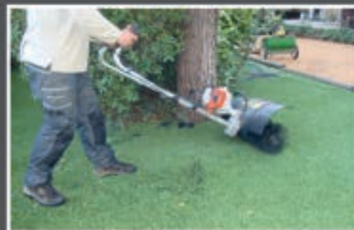
4 / Brossage de finition épandage de la silice
