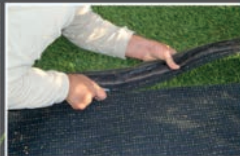
10 / Pour réaliser une jonction propre, il est impératif d'effectuer une découpe à droite et à gauche de chaque lè
