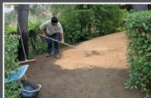
6 / Répartition du sable sur la surface
