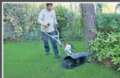
1 / Brossage de la surface pour redresser la fibre
