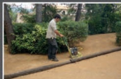
7 / Compactage de la surface avec plaque vibrante ou rouleau à gazon
