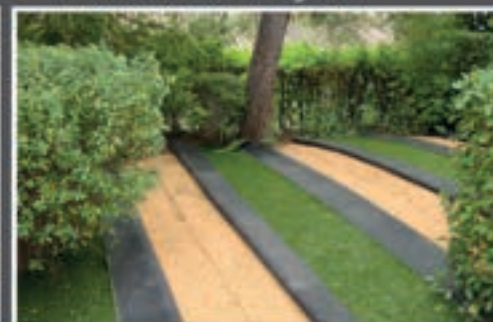
11 / Mise en place du gazon en respectant toujours le même sens
