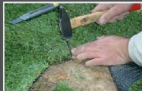
16 / Pose de fixations sur contours
