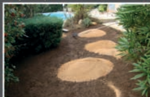
5 / Apport de sable stabilisé sur 2 à 3 cm au m 2
