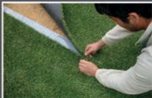
13 / Jonction bord à bord du gazon
