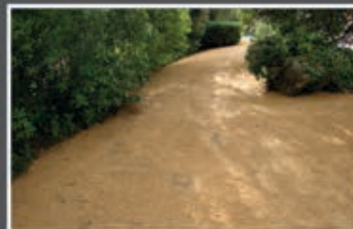
9 / Vérification du terrain avant pose du gazon
